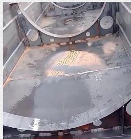
TESTE DE ESCOAMENTO BACIA DE CONTENÇÃO
